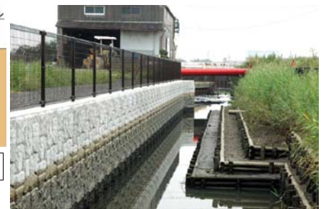
環境配慮型水路改修（階段護岸）
